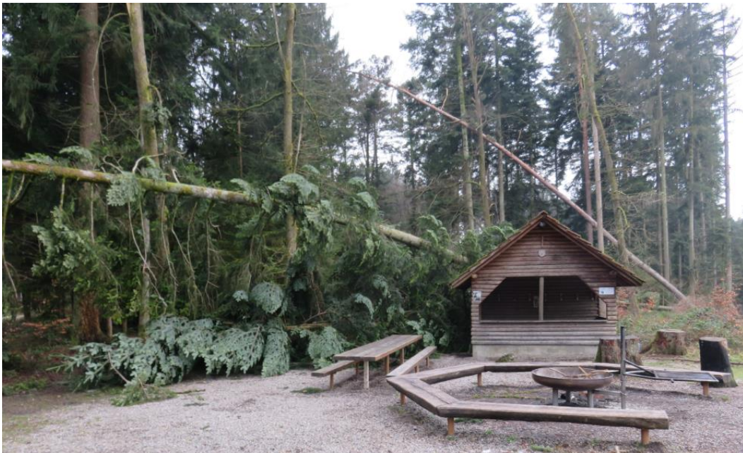
Schäden des Sturms "Burglind" vom 3. Januar 2018 am Hasenstand (Foto: Daniel Gautschi)
